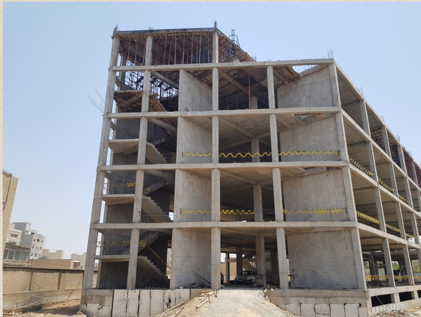
ساخت اسکلت اداری
