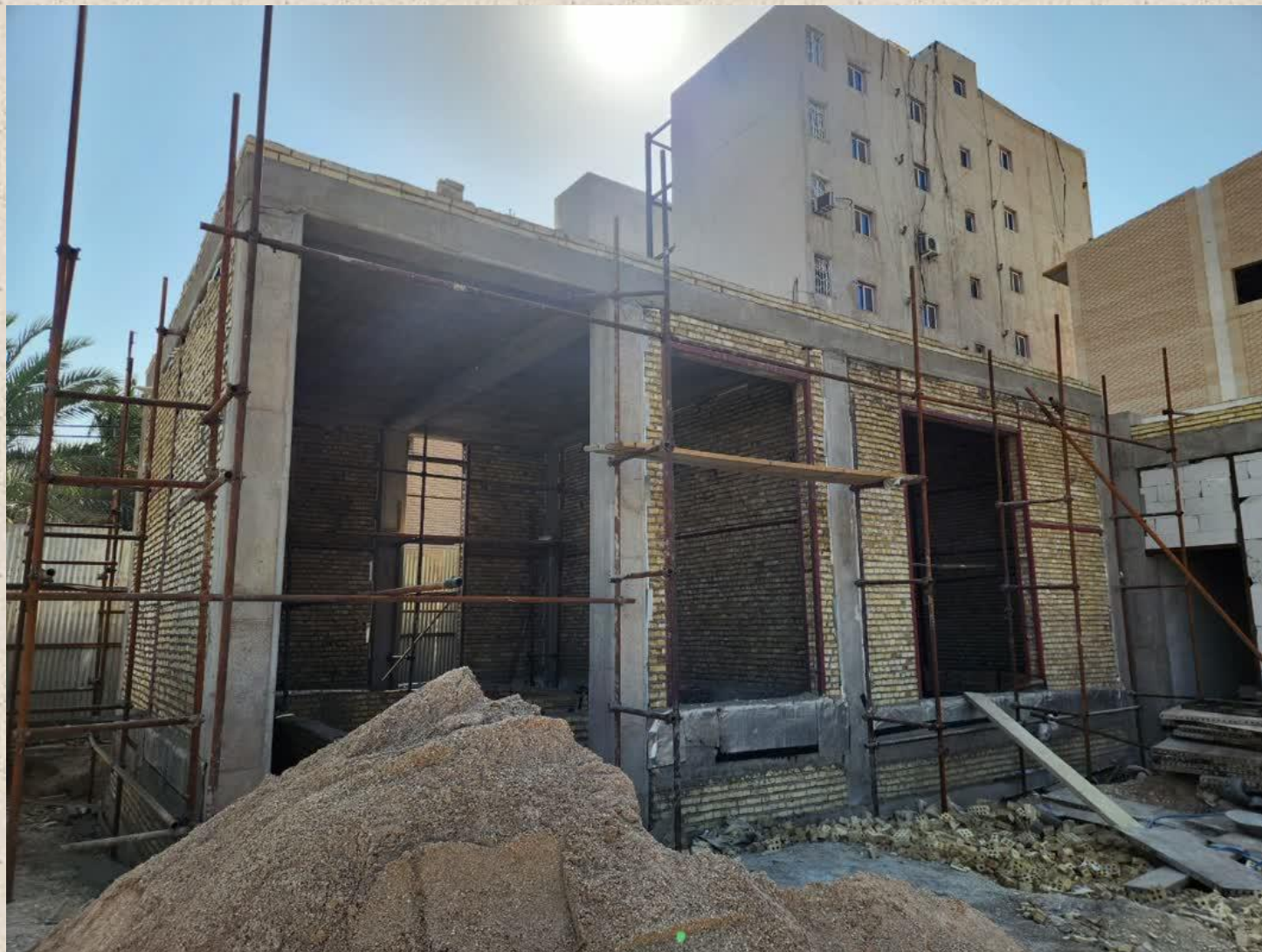
اجرای ساختمان رختکن
