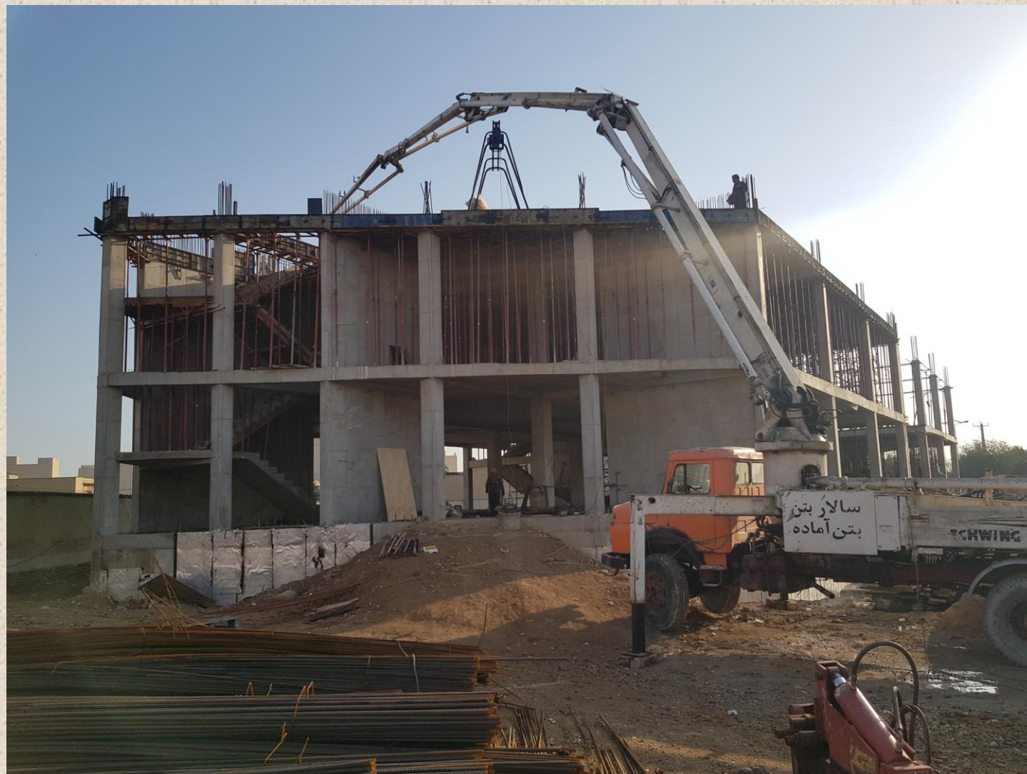
ساخت اسکلت اداری
