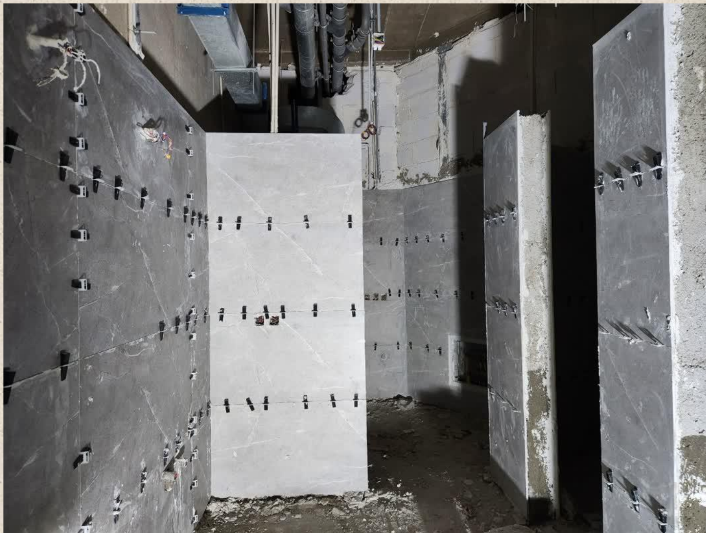
کاشی کاری سرویس های بهداشتی
