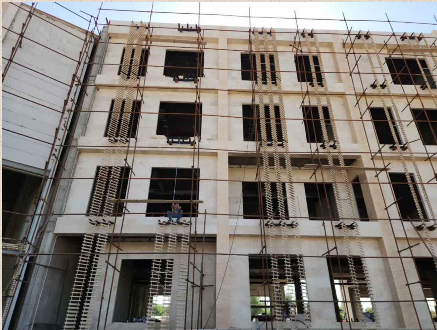
اجرای نمای کرتکس شمالی
