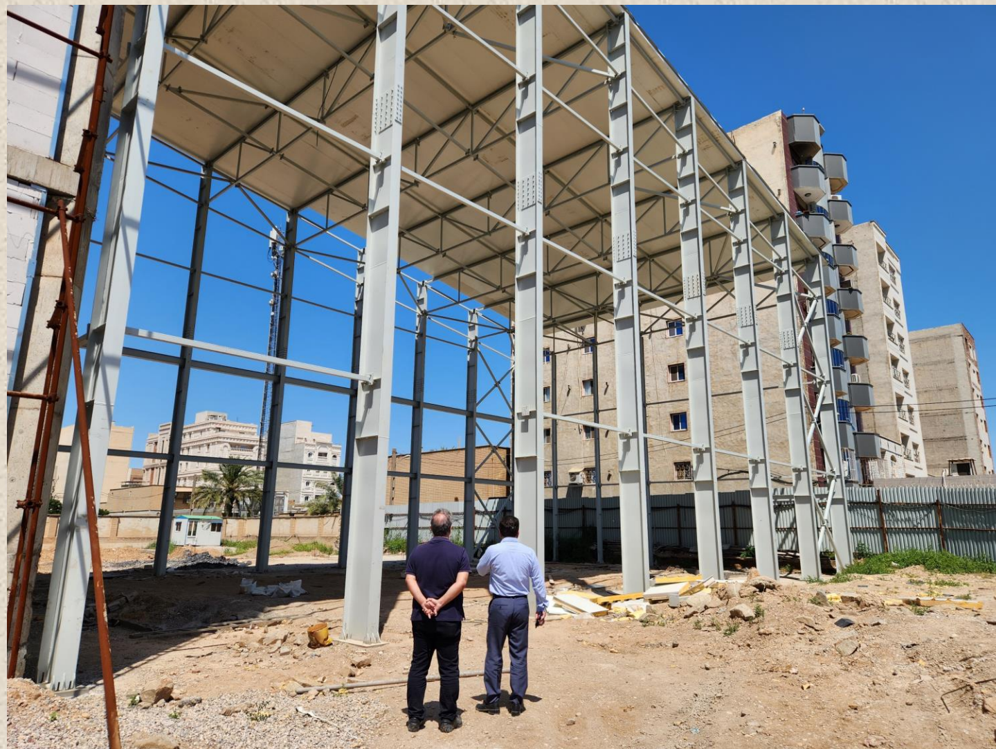
اجرای سوله ها
