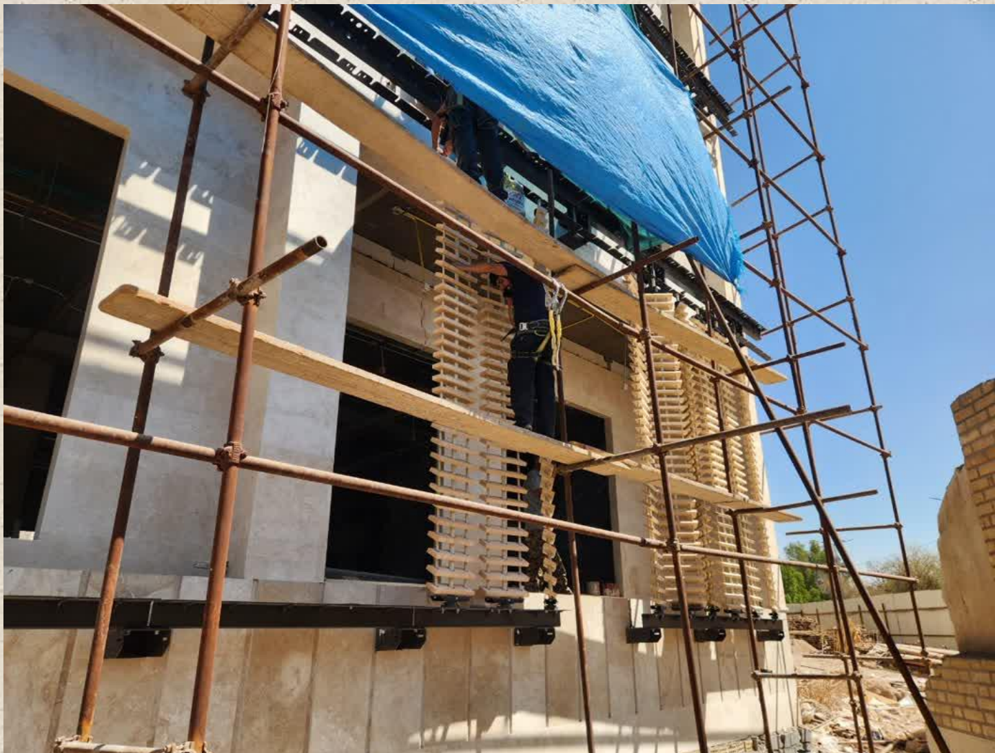
اجرای نمای کرتکس جنوبی
