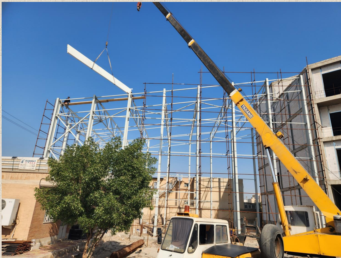
اجرای سوله ها
