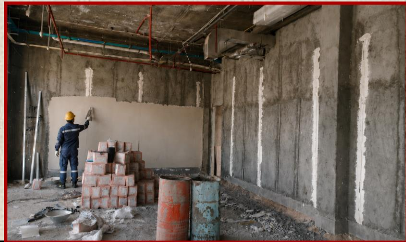
اجرای گچ کاری (۵۰٪)
