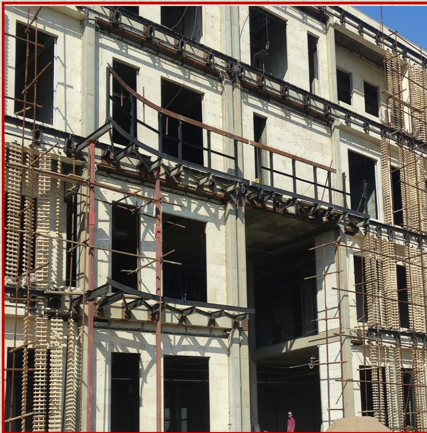
نصب سازه فلزی نمای پیکسلی
