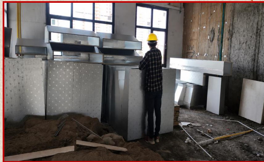
تکمیل ساخت و مونتاژ کانال های هوا زیر سقف (۸۰٪)
