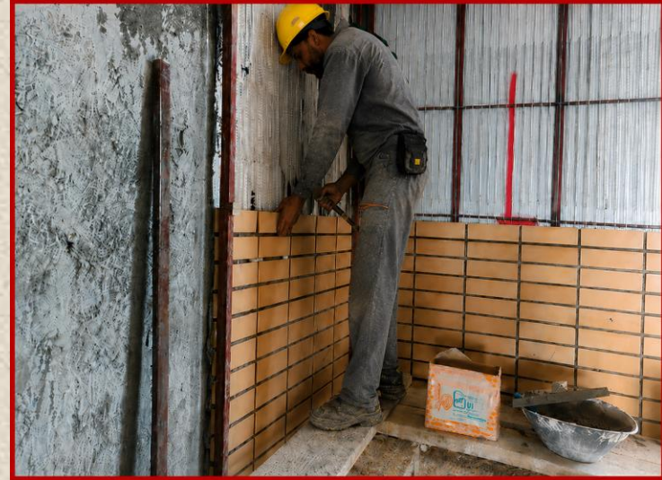
اجرای آجر نمای داخلی (۵۰٪)
