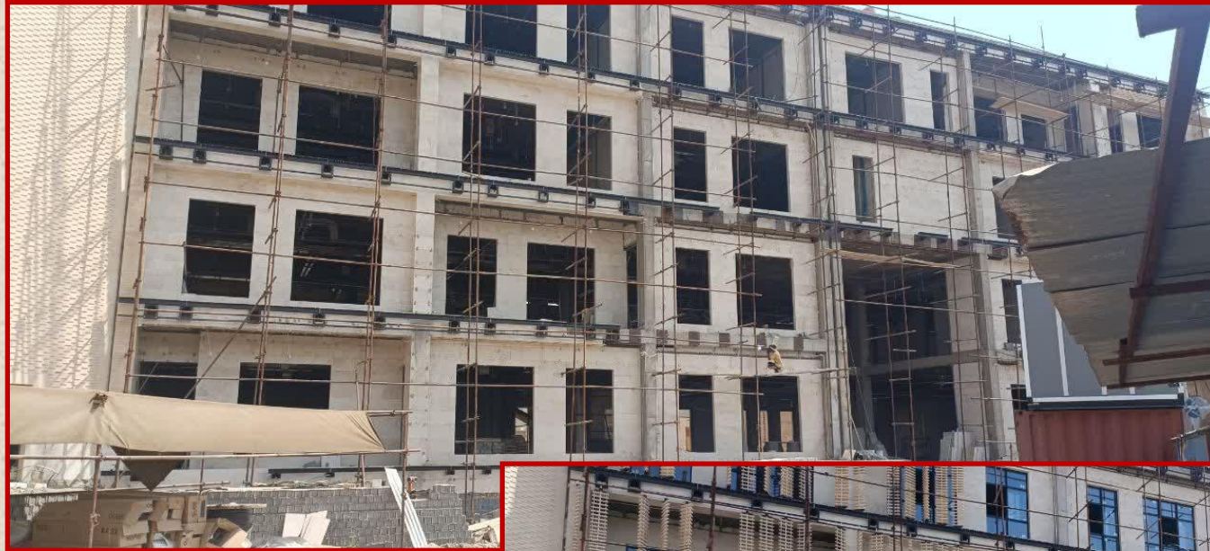
اجرای نمای آجری کرتکس و نصب پنجره‌ها
