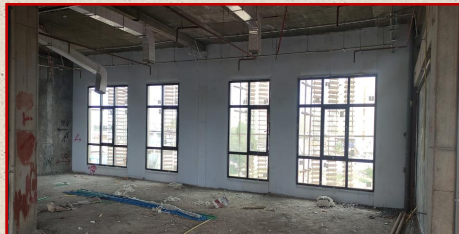
اجرای عایق حرارتی بر روی دیوارهای پیرامونی ساختمان مطابق
