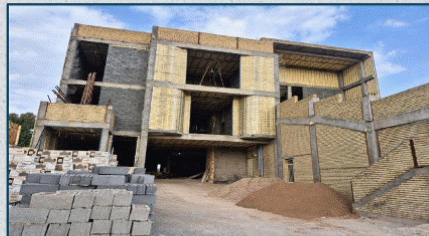
اجرای عملیات رابیتس نما جنوبی
