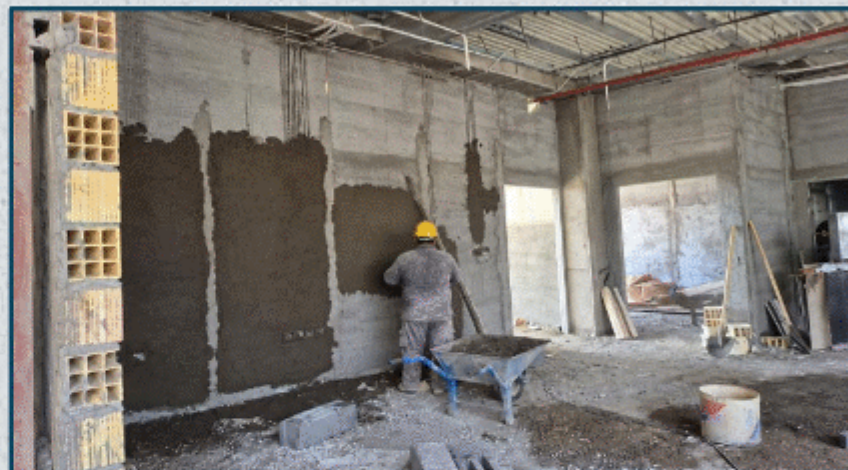
اجرای عملیات پلاستر ساختمان
