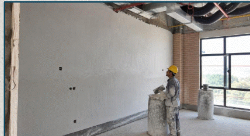
اجرای پلاستر و سفید کاری
