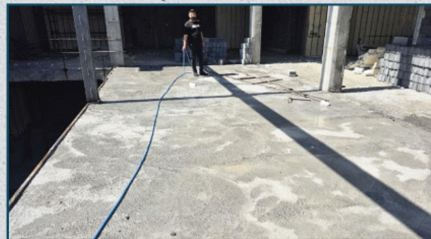
اتمام بتن ریزی و اجرای سقف تکمیلی در طبقات
