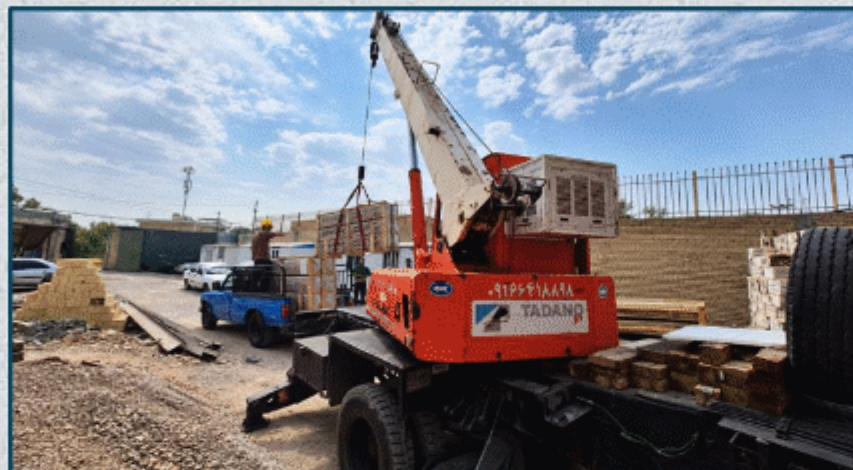
ورود مصالح و تجهیزات به کارگاه
