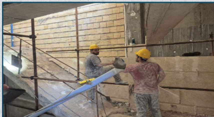
اجرای سنگ بدنه راه پله
