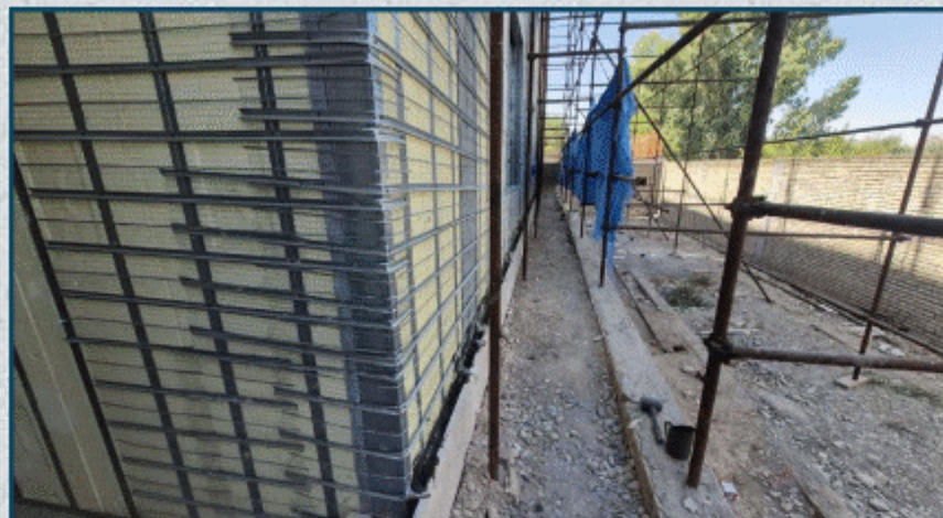
اجرای رابیتس روی دیوارهای نما بیرونی
