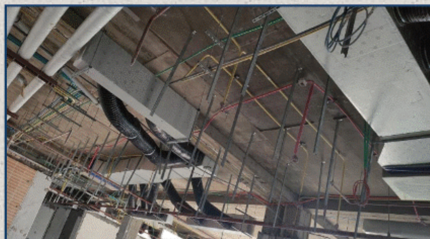
آماده سازی شاسی کشی و زیر کار اجرای کاذب کناف
