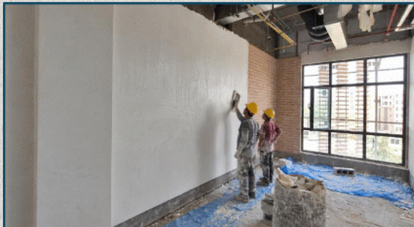
ادامه اجرای نمای آجری داخل و سفید کاری
