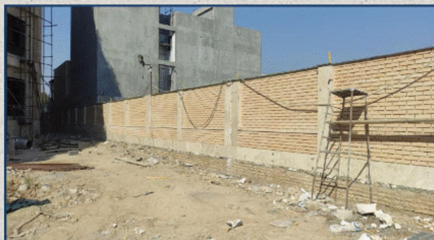
تکمیل بخشی از قسمت دیوار محوطه شمالی
