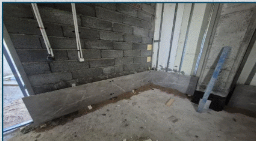
اجرای عملیات نصب سرامیک و جانمایی کلید و پریزها
