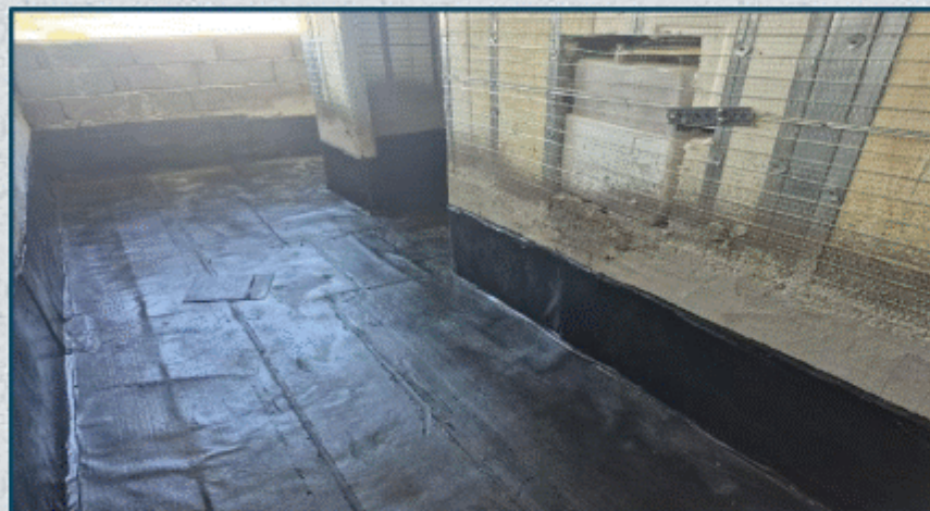
اجرای عایقکاری و ایزوگام سرویس ها
