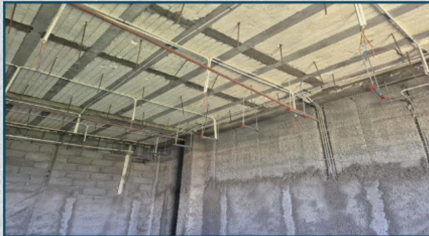
اجرای عملیات لوله گذاری و کابل کشی تاسیسات برق
