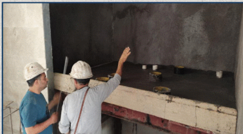
اجرای سقف آسانسور ضلع غربی
