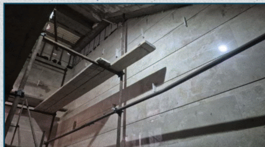
اتمام عملیات سنگ بدنه راه پله
