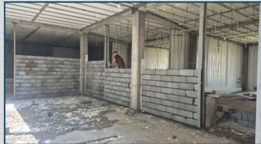
اجرای دیوار چینی و والپست ها
