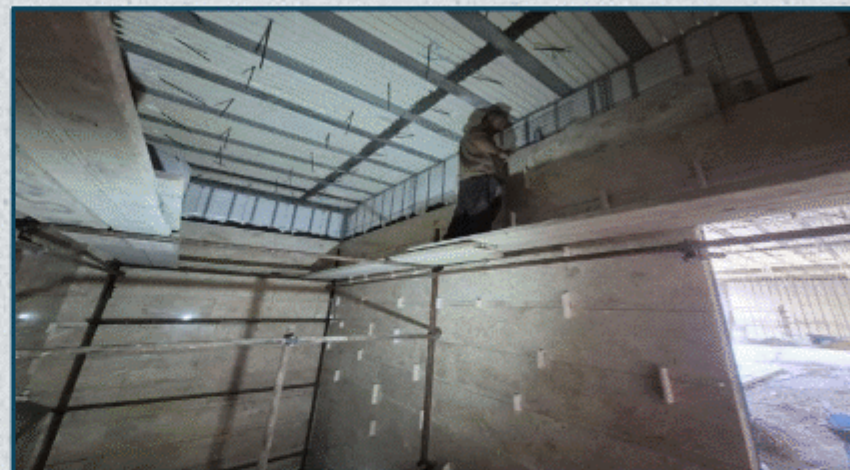
اجرای سنگ بدنه راه پله
