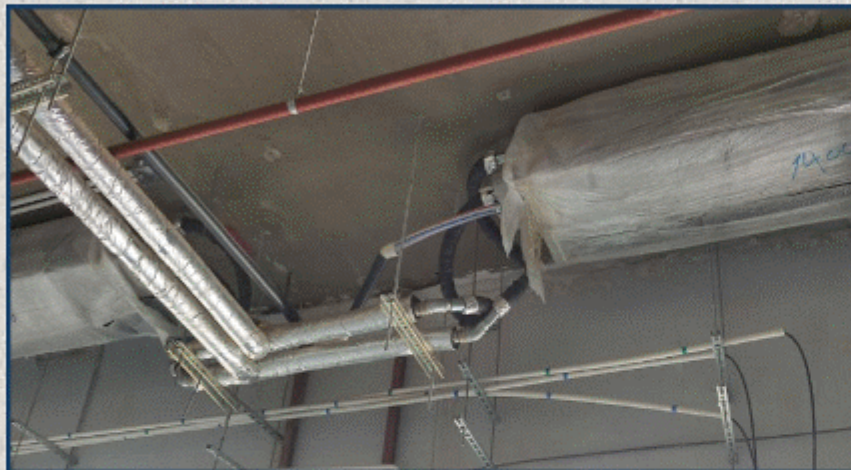
اجرای کامل اتصالات فن کویل‌ها
