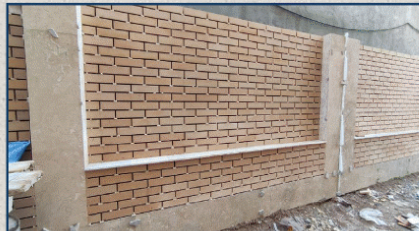
اجرای دیوار محوطه شمالی
