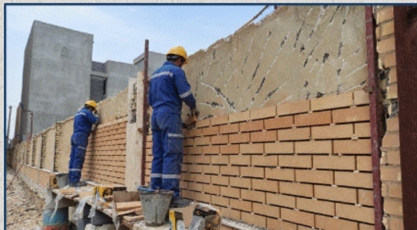
اجرای دیوار محوطه شمالی
