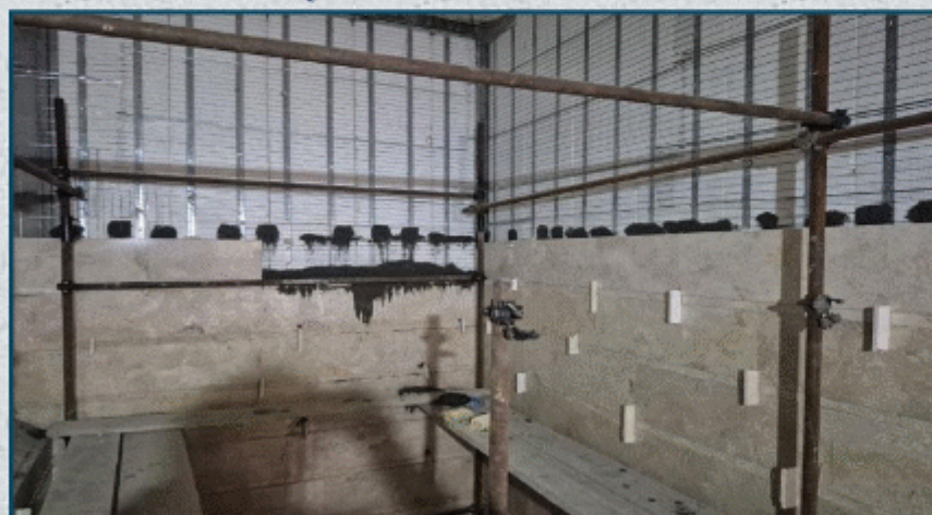
اجرای سنگ بدنه راه پله
