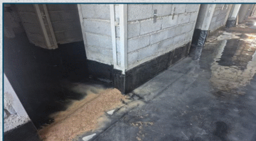
تست آب بندی کف سرویس ها
