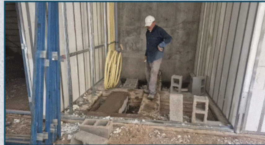
اجرای عملیات تاسیسات مکانیکی
