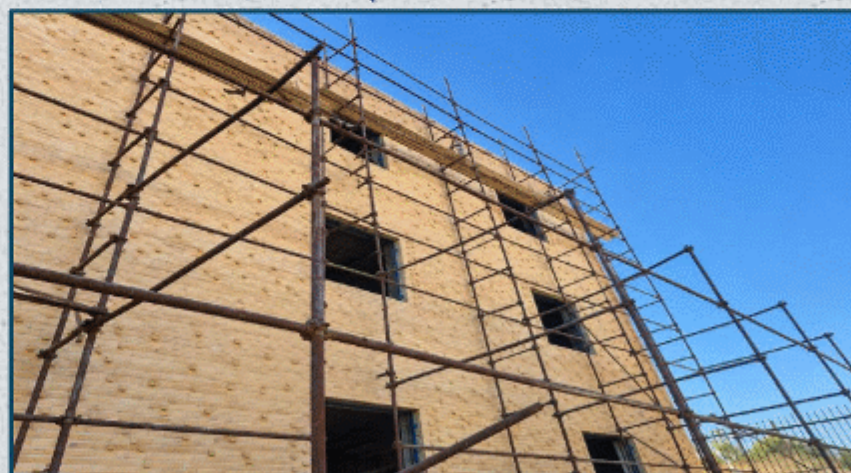
اجرای نما کاری پشت ساختمان
