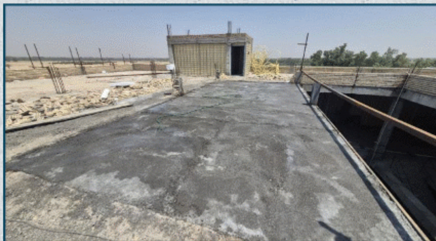
اجرای عملیات سقف های تکمیلی
