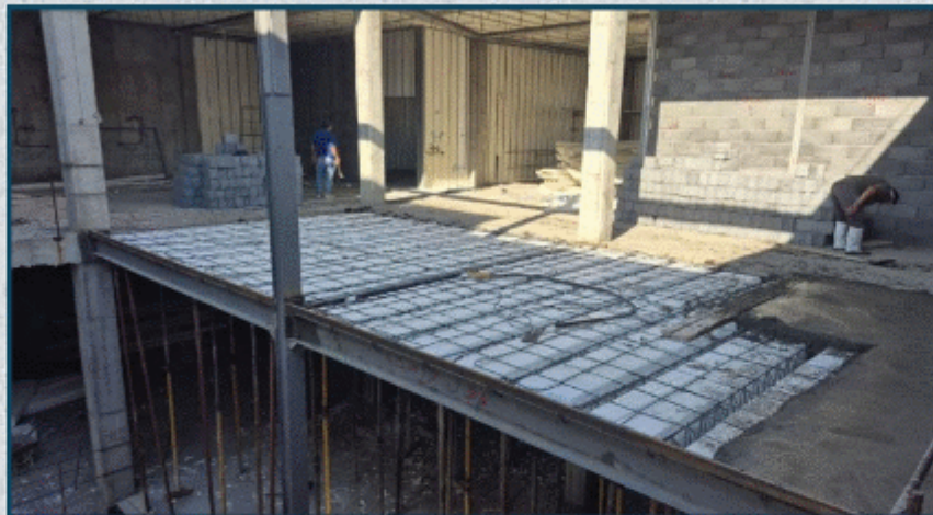
اجرای تیرچه و بتن ریزی سه سقف تکمیلی
