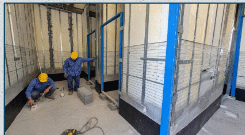
نصب چارچوب درب ها
