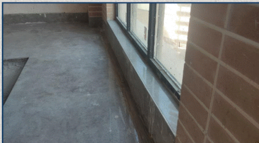
اتمام بخشی از سرامیک و نمای آجری داخل ساختمان اداری
