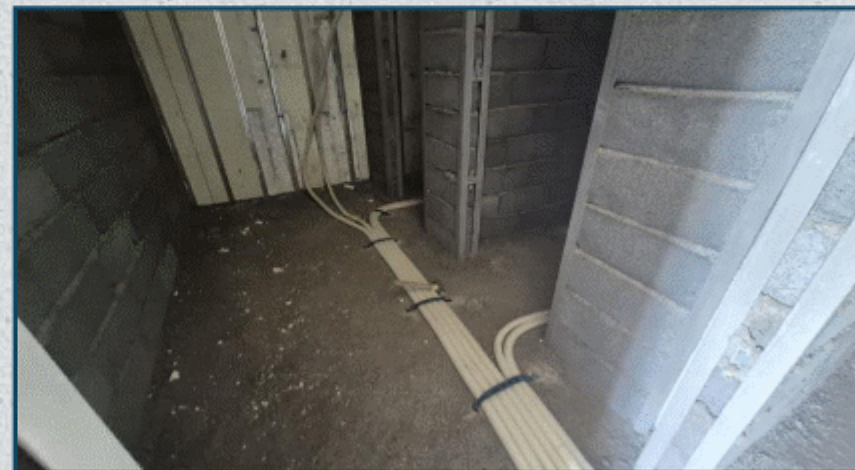
اجرای تاسیسات مکانیکی و لوله گذاری آب
