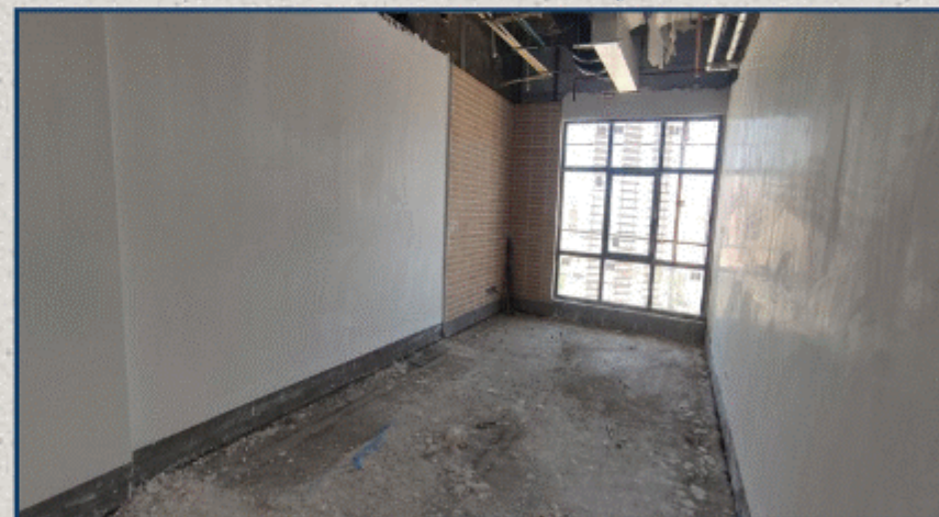
تکمیل نمای آجری داخل و سفید کاری
